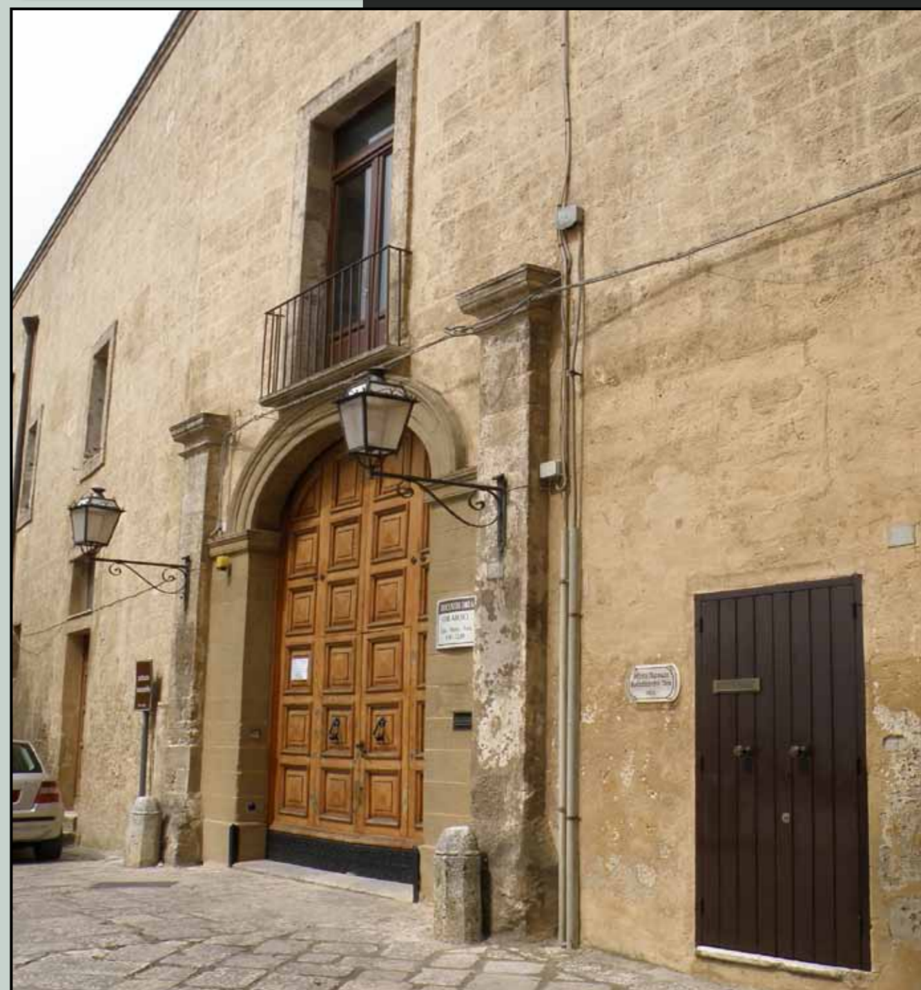
Portone d'ingresso dell'episcopio di Oria
